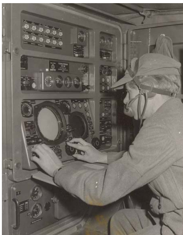
Gerätebediener am Feuerleitgerät Fledermaus Deiswill VII beim Gerätecheck
